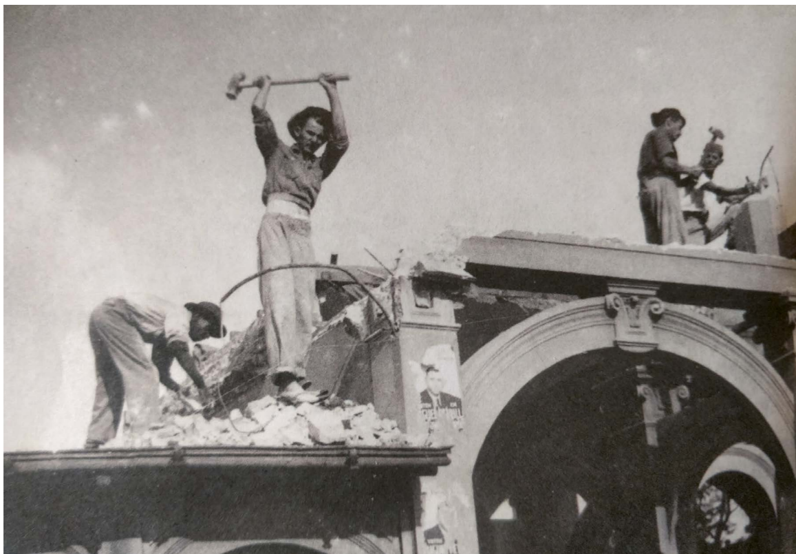
Demolição do Belvedere do Trianon, autor desconhecido. Prefeitura da Cidade de São Paulo, Secretaria Municipal de Cultura, Arquivo Histórico Municipal.
