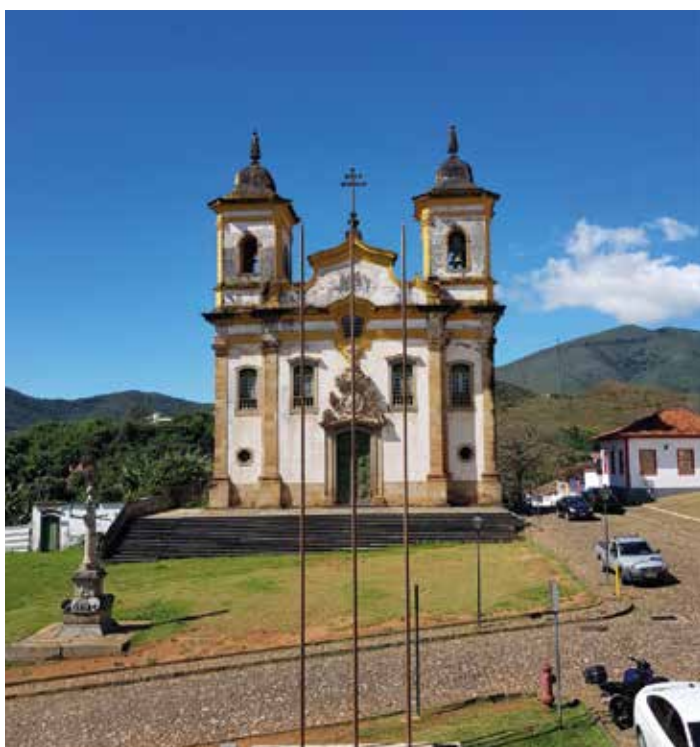
Praça de Minas Gerais, em Mariana. Podemos ver a Igreja São Francisca de Assis deteriorada, após um longo tempo sem reparo. (Foto dos autores)
